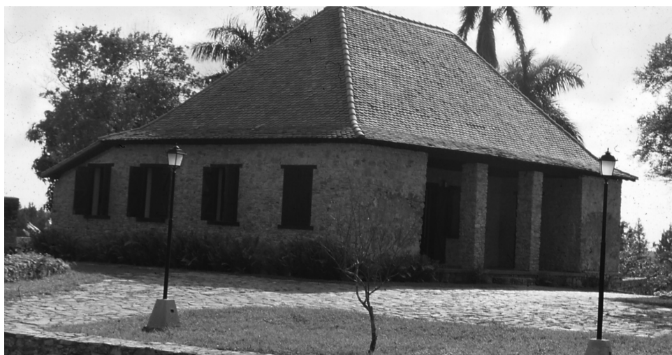
Casa de Vivienda restaurada. Cafetal “Buena Vista”. Pinar del Rio.
